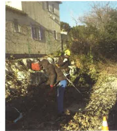
Travaux d'élagage et de débroussaillage
