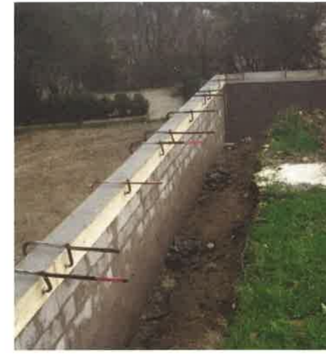
Construction du mur de soutènement au cimetière
