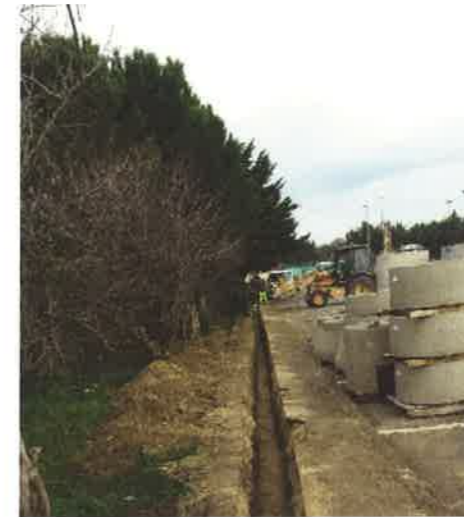
Réparation de la fuite d'eau au stade
